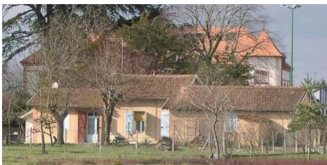
L'ancienne gare de Montbeton
