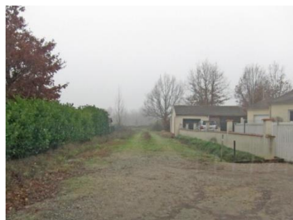
Accessibilité du site à partir de la voie riveraine se branchant sur le chemin Montagne à hauteur de l'EHPAD
