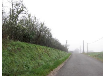
Léger talus en marge du chemin de l'Evêque autorisant pour autant la création d'un accès
